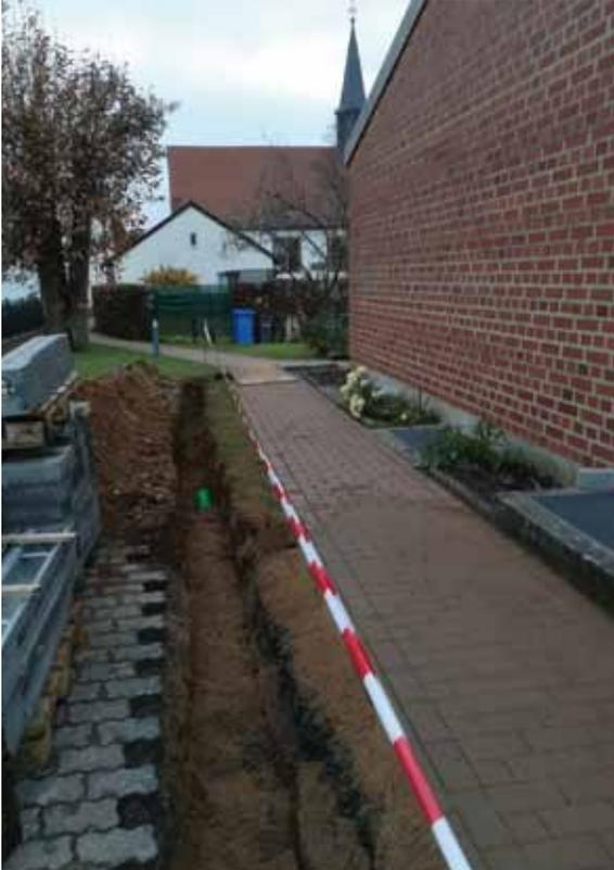
Ein neuer Kanal für das Regelfallrohr an der Westecke vom Gemeindehaus ist notwendig, da der alte Kanal nahezu zugesetzt ist.
