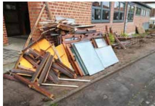
*Die alten Fenster wurden durch neue Fenster ersetzt, außen Aluminium, um der Witterung besser zu widerstehen, innen Holz*
