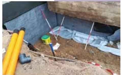
*Die nassen Außenmauern um das ehemalige Kaminzimmer wurden freigelegt, die Drainage erneuert und die Mauern aufwändig abgedichtet*
