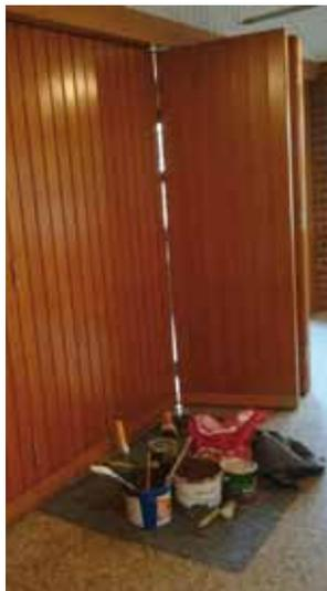
*Die Innentüren und die Trennwand zwischen den Sälen wurden angeschliffen, um die Gebrauchsspuren der Vergangenheit möglichst zu beseitigen, und neu lasiert*
