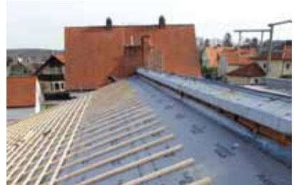
Mit einer Absperrbahn und der neuen Lattung war das Dach bereit für die neuen Ziegel. Damit konnte mit etwas Mehraufwand ein gut gedämmtes Dach realisiert werden, um Heizkosten zu
