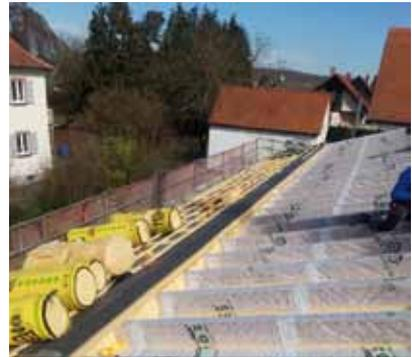
Besonders aufwändig gestaltete sich die Dachdämmung auf der Pfarrhausseite. Unter den Sparren, zu den Sälen hin, waren Asbestplatten als Brandschutz angebracht. Diese wurden sehr sorgfältig im Schlingenverfahren isoliert und zwischen den Sparren wurde eine 20 cm dicke Dämmschicht eingebracht.
